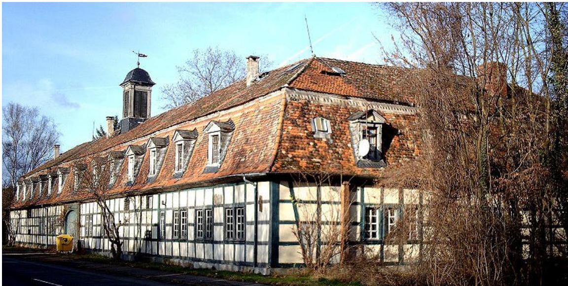
Das Wirtschaftsgebäude an der B 486 im heutigen Zustand
